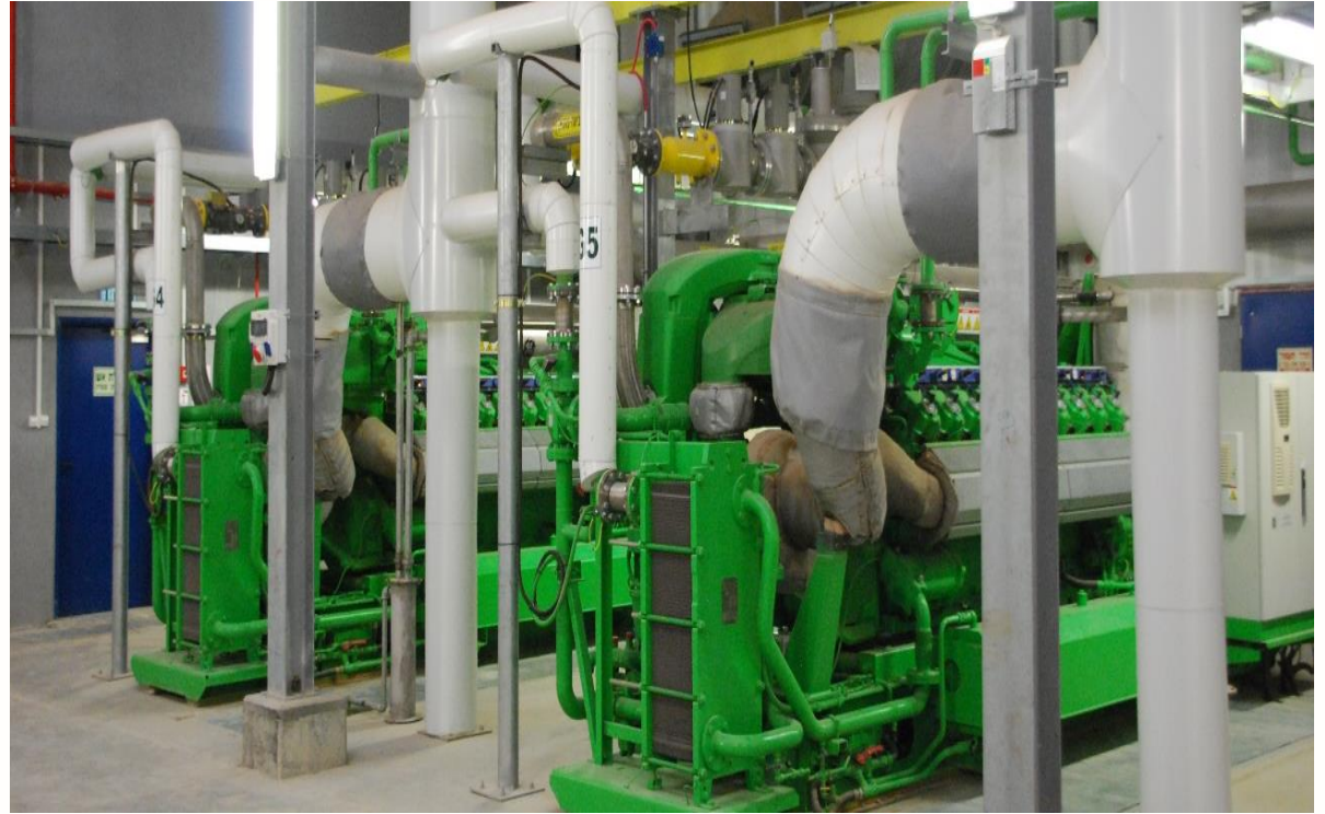
פרויקט גני הדס דודאים 5 מנועי GE – Jenbacher בהספק חשמלי כולל של 7 MW
