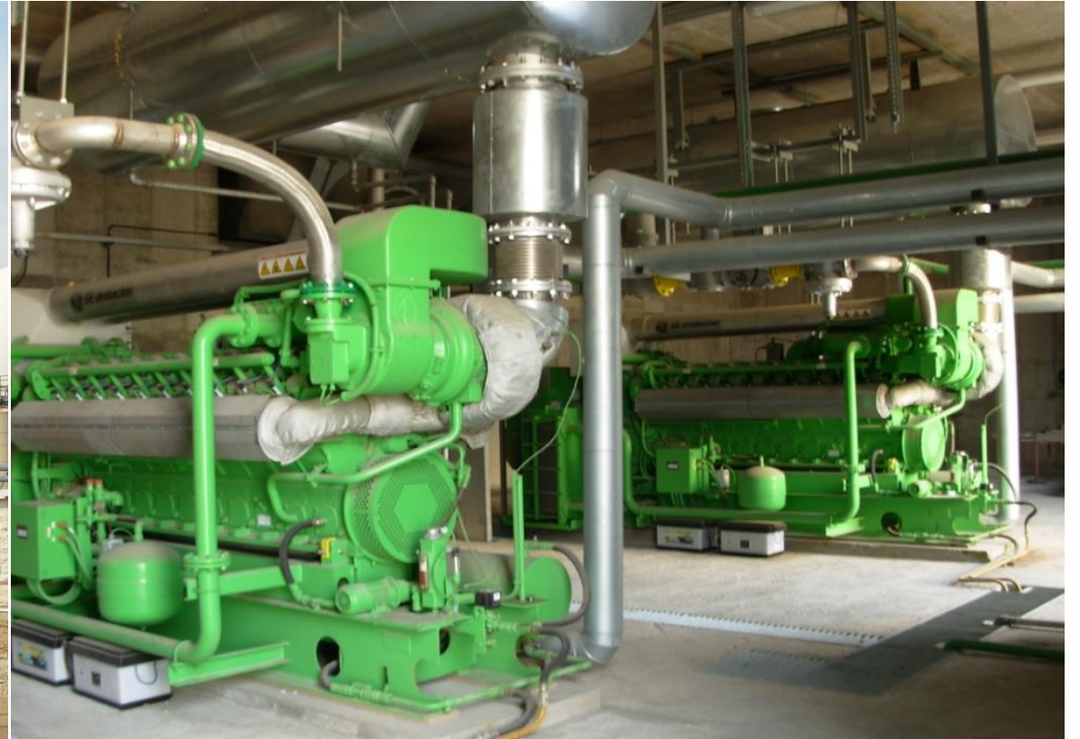
פרויקט ביו-גז עמק חפר 2 מנועי GE – Jenbacher בהספק חשמלי כולל של 2.2 MW (קוגנרציה)
