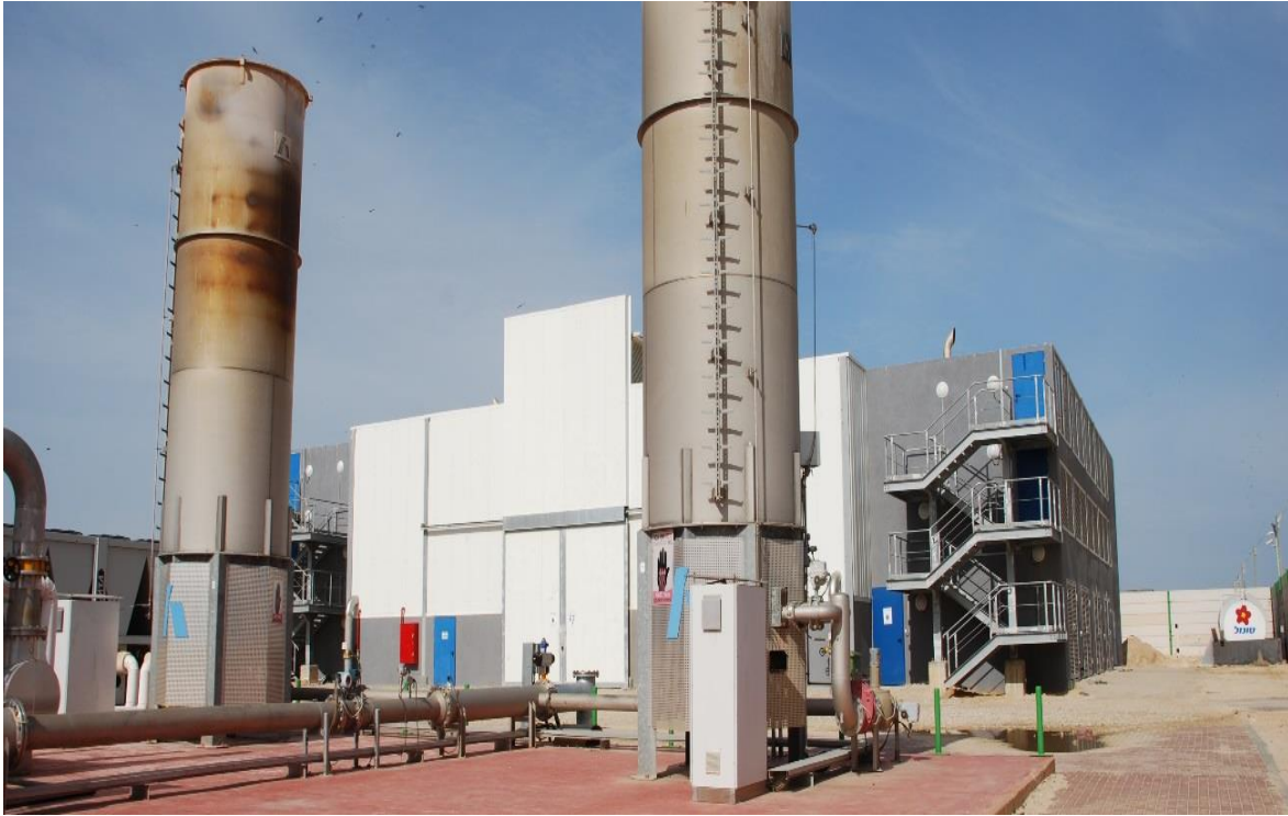
פרויקט גני הדס דודאים 5 מנועי GE – Jenbacher בהספק חשמלי כולל של 7 MW
